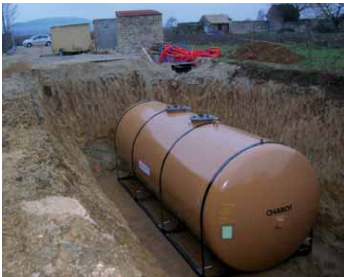
Cuve enterrée pour le stockage des effluents phytosanitaires de l'aire collective de Meursault
