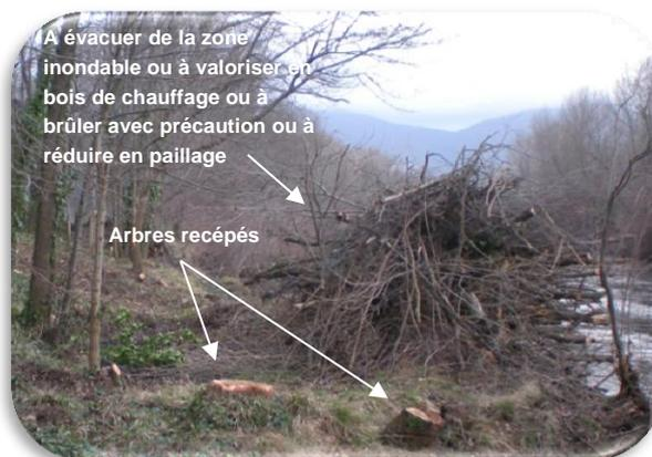
**Enlever les embâcles\*** (branches et troncs d'arbres) qui entravent la circulation de l'eau manuellement ou à l'aide d'un **engin motorisé sur berge** pour les tirer.
