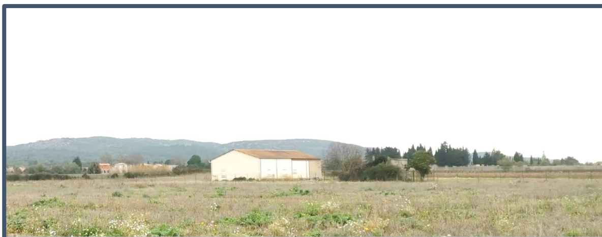
Figure 3 : Vue du Hangar depuis le Nord du site.
