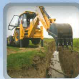
Aménagements de drains
