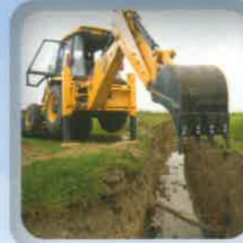
Aménagements de drains
